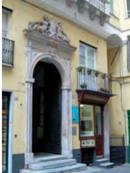
right: Palazzo Ambrogio Di Negro, the façade on Piazza Banchi and the courtyard. Palazzo Gio. Battista Grimaldi. below: Palazzo De Marini-Croce.
